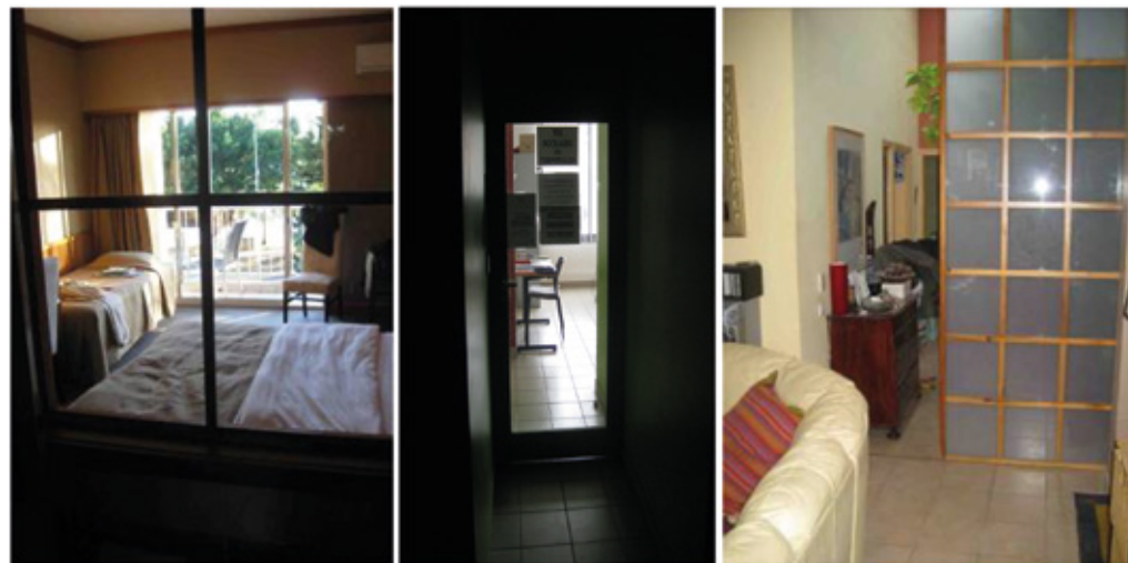
Second-jours dans une paroi de SdB/chambre - dans une porte fixe - dans une cloison coulissante
