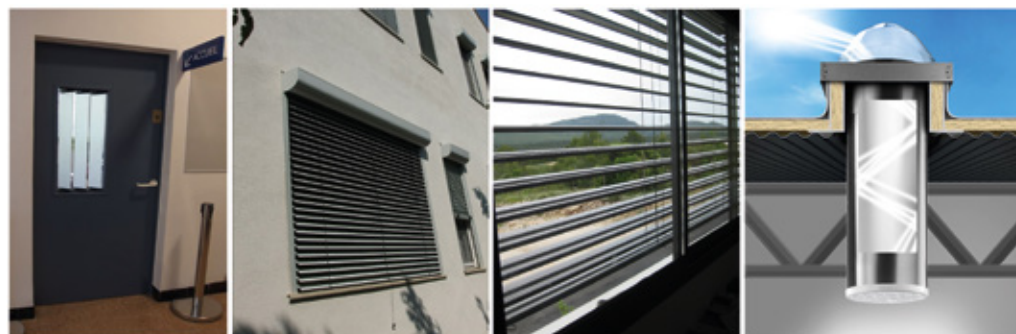
Second-jour ouvrant dans une porte – BSO vues extérieure et intérieure – Tube ou canon à lumière
